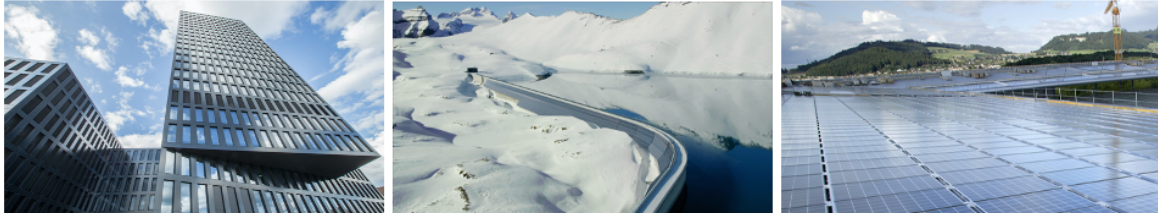
Bilder: BIPV-Solarkraftwerk Grosspeter Tower Basel, Solarkraftwerk KLL-Staumauer Muttssee, Stadion-Solarkraftwerk ‚Stade de Suisse‘ Bern.
